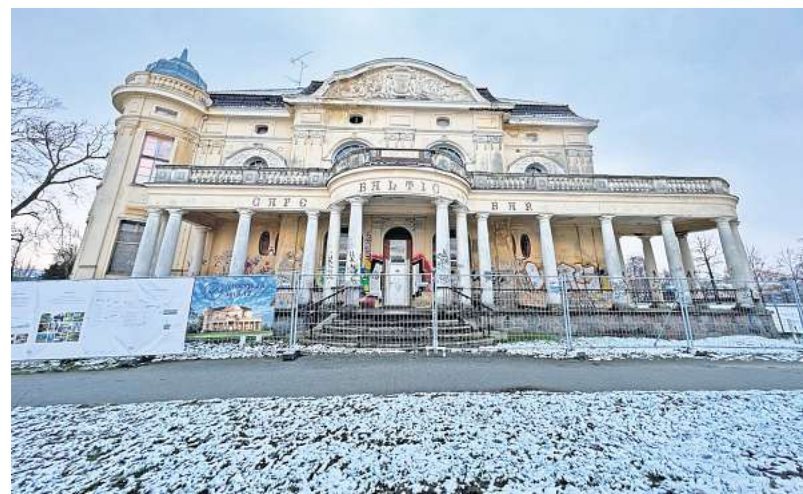
Die verfallene Villa Baltic in Kühlungsborn West vor einem Jahr beim Bürgerentscheid: Inzwischen ist hier noch immer nicht viel passiert. FOTO: LENNART PLOTTKE
