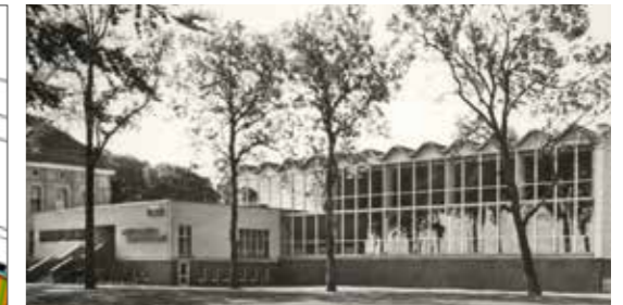
Anbau ehemalige Schwimmhalle
